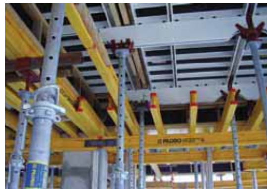
Sistema misto di cassetta per solai con travi in legno PL20 e casseforme industriali SLABFORM per il solaio di una grande opera industriale con molte travi ribassate.
